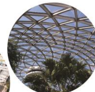
New roof at Bloedel 2014
